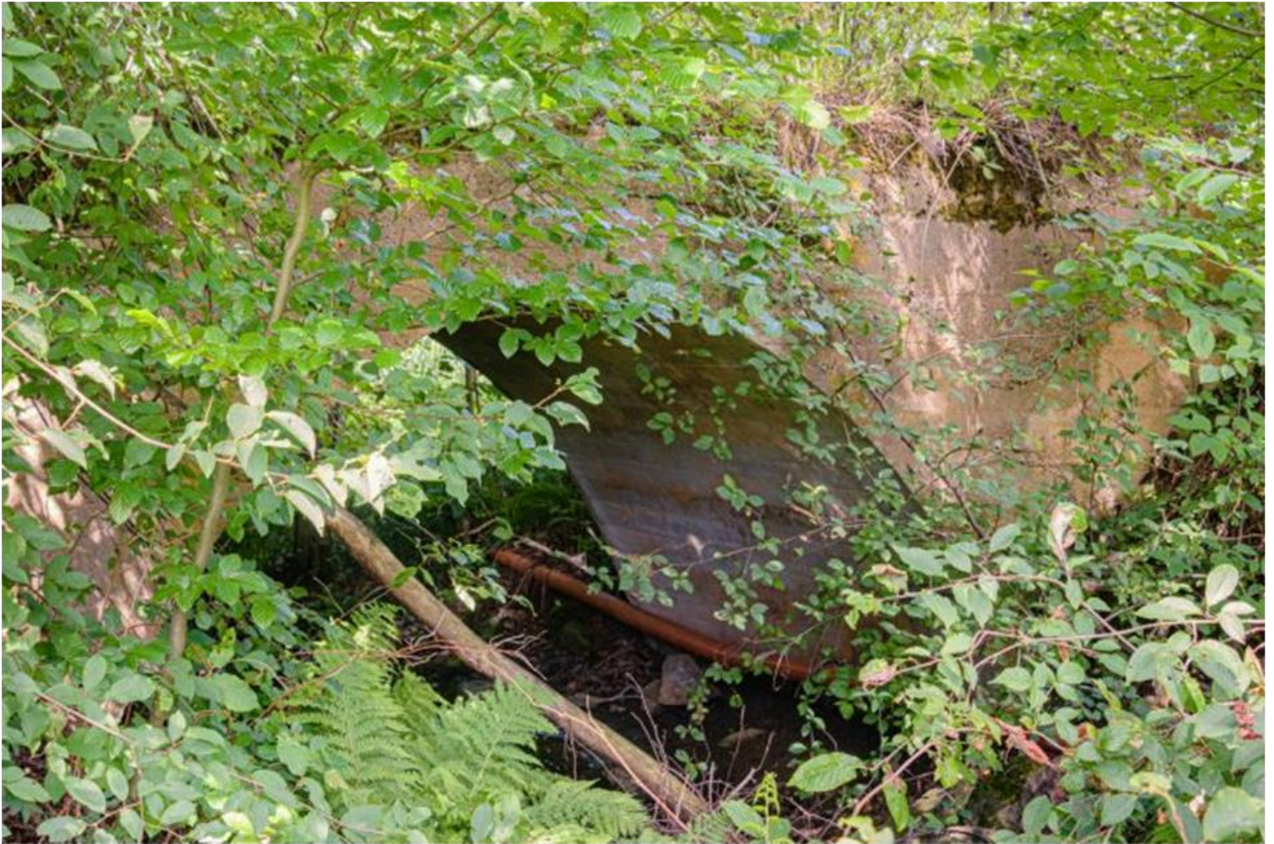
Abb. 1: Brücke über den Bürgerbach bei Plankenhammer (Foto: Armin Weth, aufgenommen am 16.07.2017).
